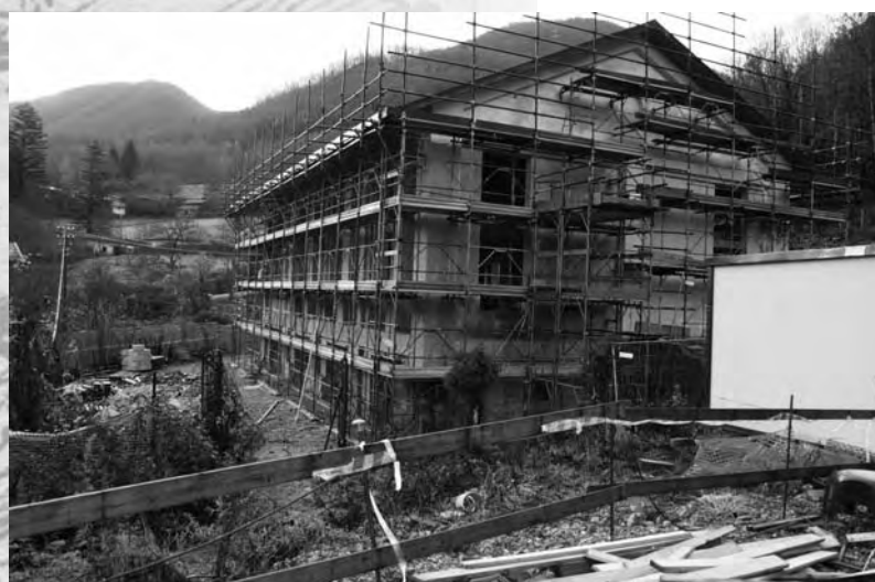
Momenti della costruzione del Dynamo Camp (2006-2007)
